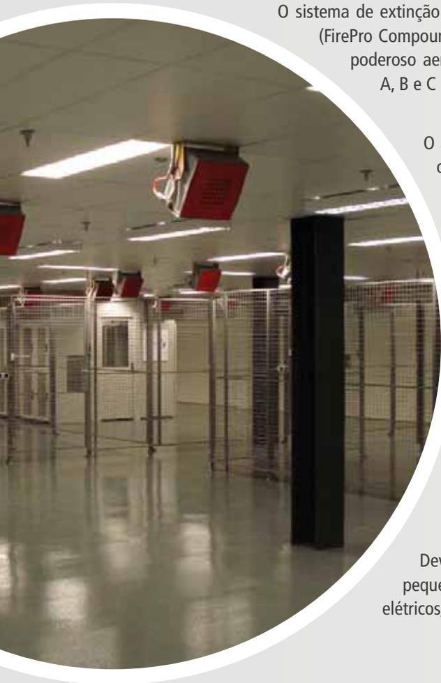
O sistema de extinção automática de incêndios da FirePro é baseado num composto sólido designado FPC (FirePro Compound), rico em sais de potássio (K), que quando ativado transforma-se rapidamente num poderoso aerossol o qual permite a extinção de incêndios de classe A, B, C e F (segundo EN2) e A, B e C (segundo NFPA 10).
