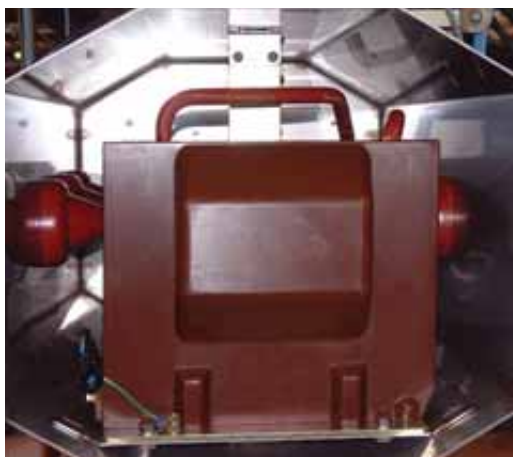
> VCS-36 Transformador de tensão tipo suporte com alimentação em interruptor aéreo de média tensão.
