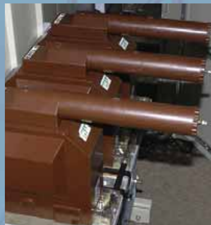
› UCJF-24 Transformador de tensão com fusível integrado, reduz o espaço necessário na célula.
