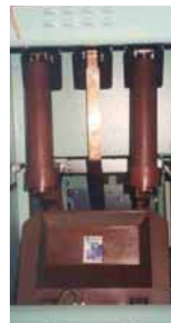
> Transformadores de tensão tipo suporte com fusível VCT.
