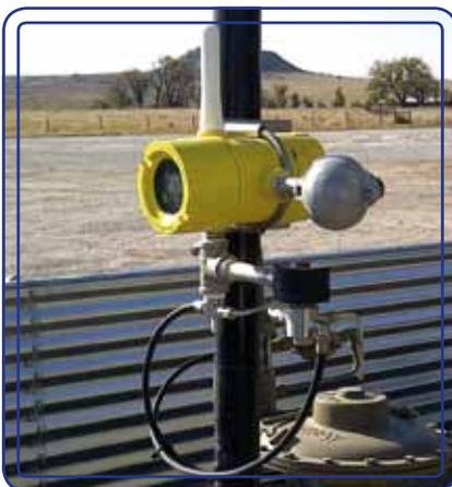
A Instrumentação sem fios auto-alimentada possibilita realizar projetos de instrumentação minimizando custos de instalação. As baterias permitem uma autonomia de cerca de 5 anos e o tempo de colocação em serviço é muito baixo.
